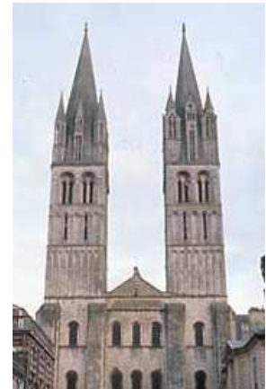
Façade harmonique de l'abbatiale Saint-Étienne de Caen construite par Guillaume.
