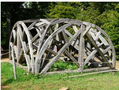
Le cintre en bois d'une voûte d'arête.
